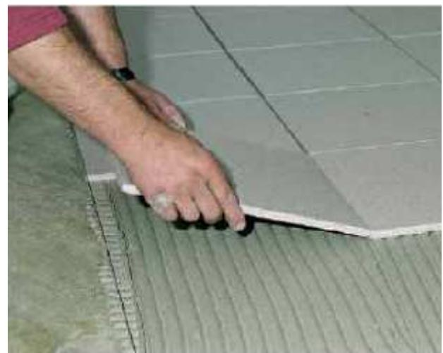
PCI Nanoflott применяется в качестве балластного слоя при укладке плитки, а также в качестве традиционной мастики.
