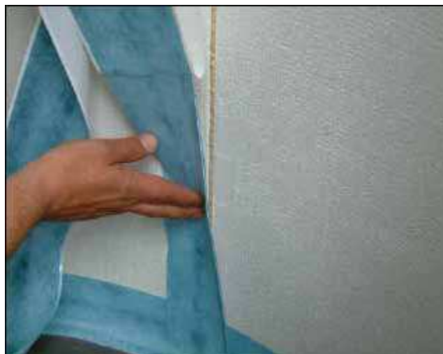
PCI Pecitape WS приклеивается непосредственно на основание
