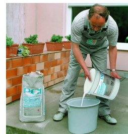
1. Перелить жидкий компонент PCI Seccoral 2K в
