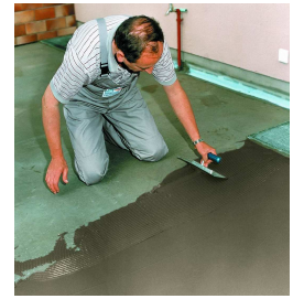
4. Наносить последующий слой раствора, после того, как предыдущий слой не клеится, но ещё не окончательно высох.
