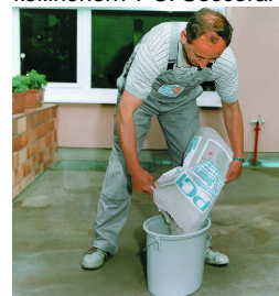
2. ...добавить порошковый компонент PCI Seccoral 2K и перемешать до образования однородной массы.
