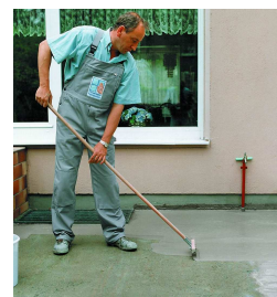
3. На предварительно увлажнённое основание нанести первый слой PCI Seccoral 2K (жидкий компонент, разбавленный 10% воды), покрывая при этом всю поверхность основания.
