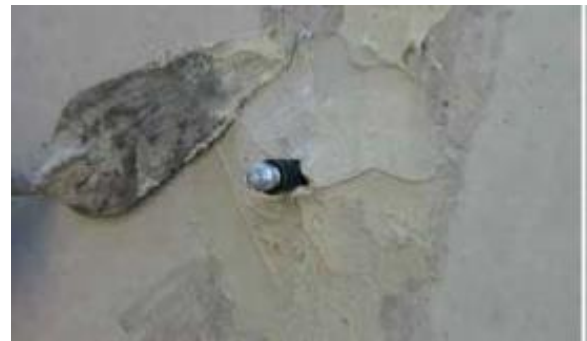
Рисунок 2. Герметизация пакера, установленного на поверхности и трещины при использовании соответствующего состава MasterFlow®.
